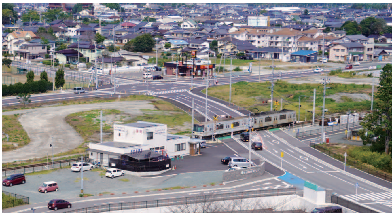
昨年10月に当院の屋上から撮影した写真です。8月に御代志木原野線の交差点移設工事が完了し、病院前の道路が通りやすくなりました。
